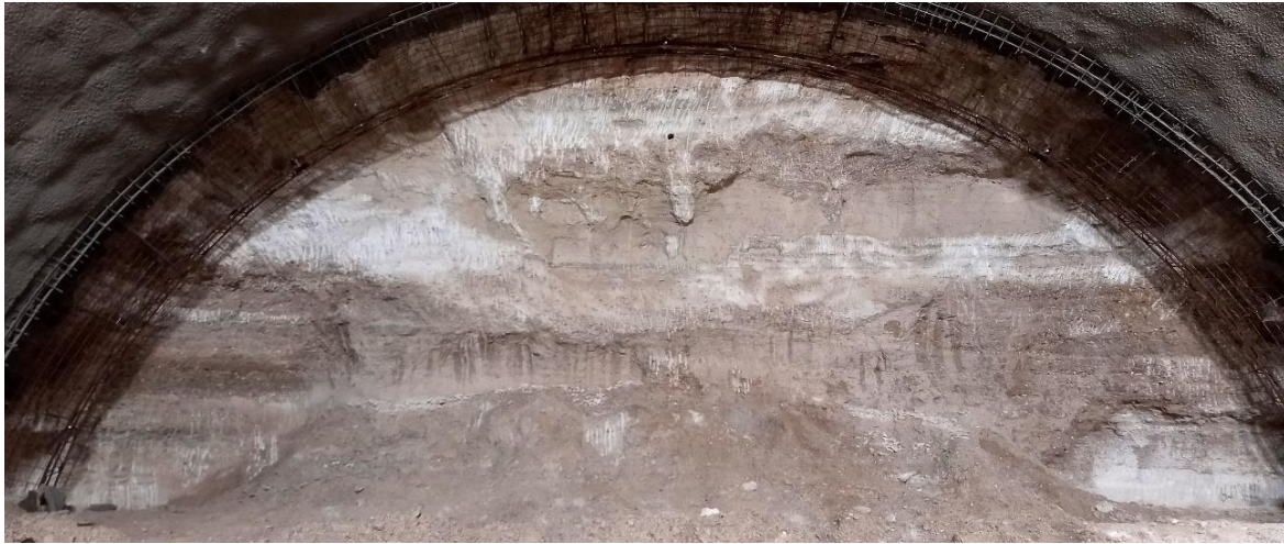
2. ábra: A konglomerátum és kavicsrétegek váltakozása egy fejtési homlokon belül az Északi alagútban.
