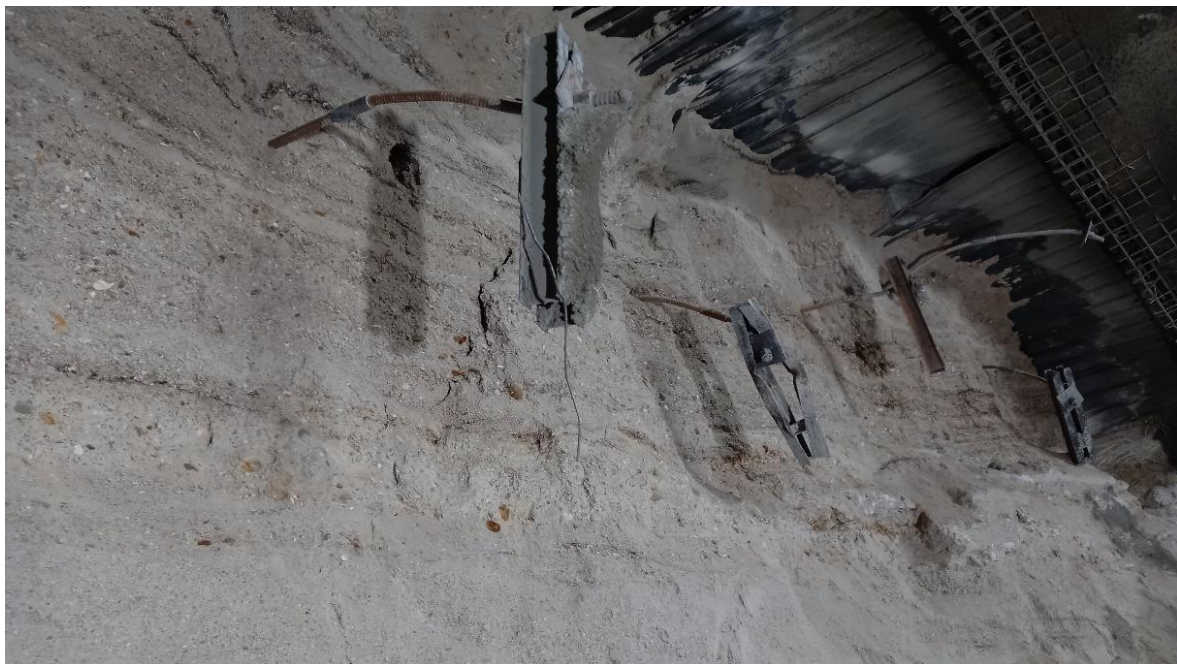
1. ábra: A K3/2 homokos kavicsanyag a Déli alagútban a rétegek stabilizálására beépített pátrialemezekkel és homlokhorgonyokkal
